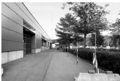
Die Baugespanne lassen Gutes ahnen.
